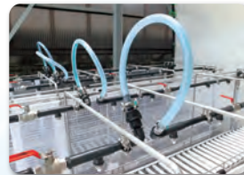
2台をドッキングしたらホースを接続
