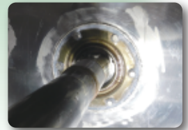
軸受部の防錆対策コーキング
