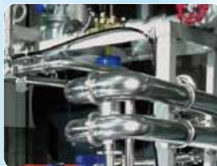
火入れ装置のホールディング管製作
