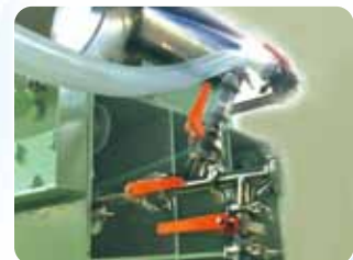
圧搾機の配管部サニタリー化
